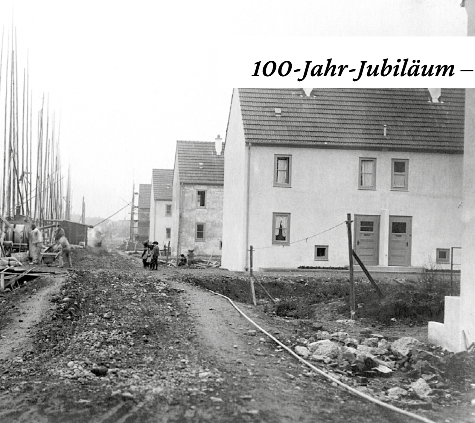
Blick von der Grüzefeldstrasse auf die im Bau befindliche Siedlung im Jahr 1925. Die ersten Häuser sind bereits bezogen und entlang des Eigenheimwegs stehen die Schnurgerüste für die zweite Etappe.
